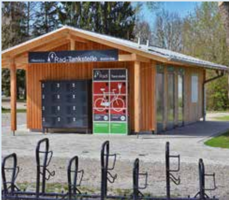
Servicestation in Bernau-Felden im Chiemseepark (CL)
