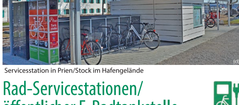
Servicesstation in Prien/Stock im Hafengelände
