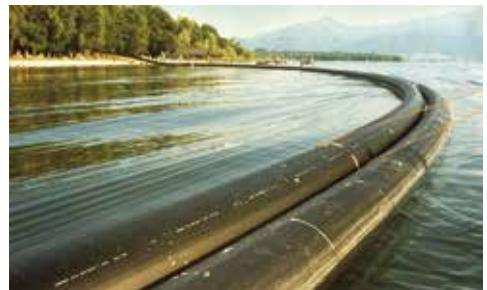
Ringkanal - vor der Rohrabsenkung
