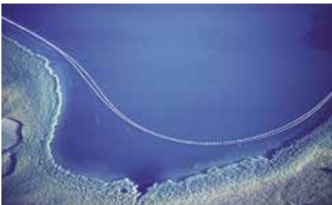
Ringkanal - vor der Rohrabsenkung
